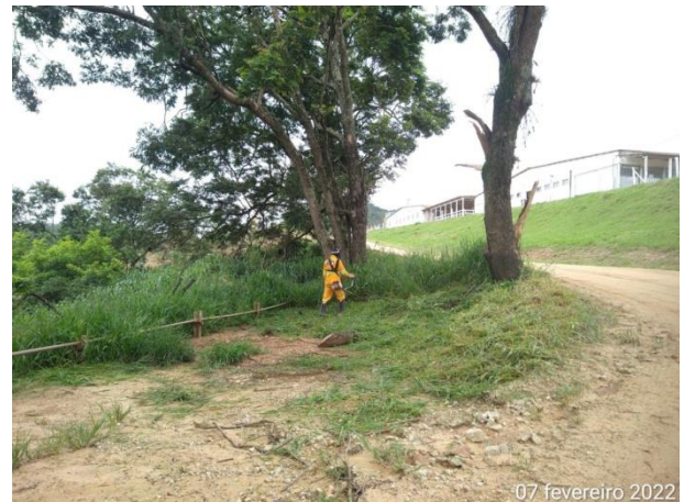
Foto 4 – Roçagem no canteiro Industrial. Data: (07/02/2022)
