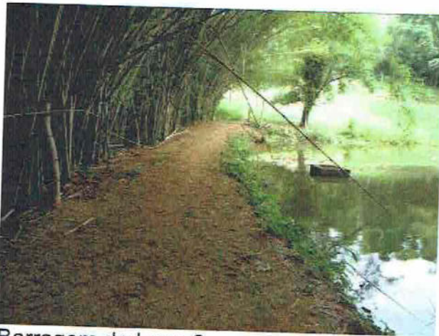
Barragem do Lago 2
