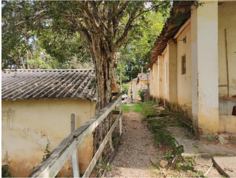
Foto 1 – Antigas edificações Fazenda Ingatuba – Atual Canteiro Administrativo
