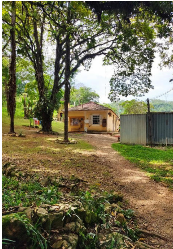
Foto 4 – Antigas edificações Fazenda Ingatuba – Atual Canteiro Administrativo
