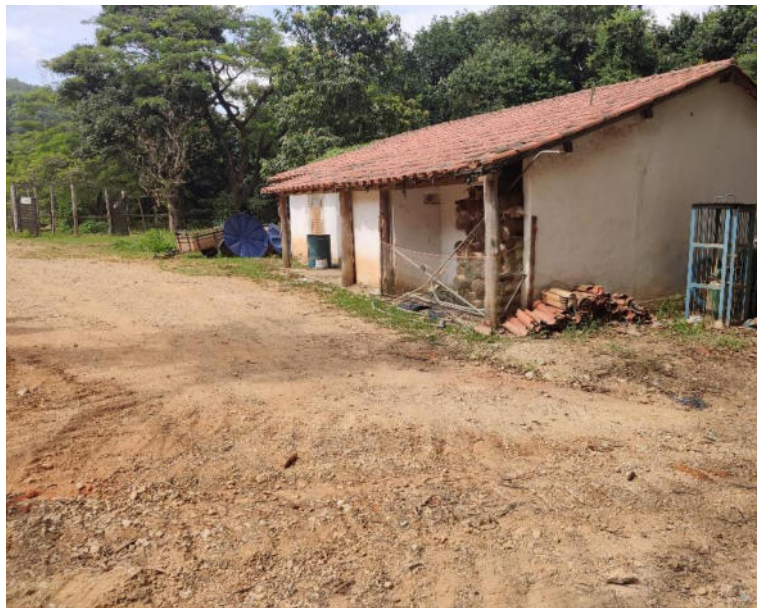
Foto 2 – Antigas edificações Fazenda Ingatuba – Atual Canteiro Administrativo
