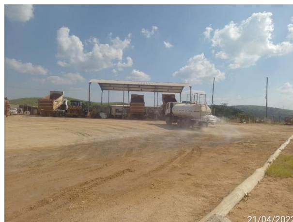
Foto 14 – Umectação, prevenção suspensão de poeira, no canteiro operacional. Data: (21/04/2022).
