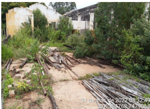
Foto 9 – Piso de concreto na parte externa do curral.
