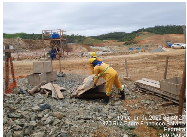
Foto 2 - Limpeza e organização nas frentes de serviços. Data: (10/01/2022)
