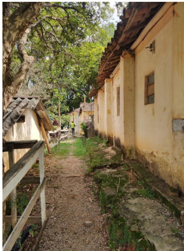
Foto 6 – Antigas edificações Fazenda Ingatuba – Atual Canteiro Administrativo
