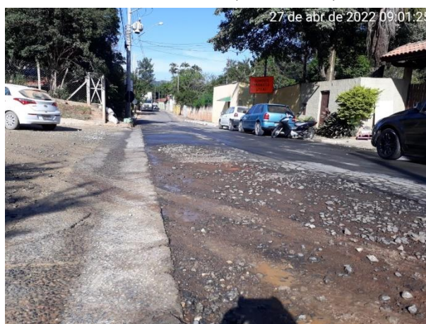
Foto 15 – Umectação, prevenção de suspensão de poeira da via MD03, entroncamento rua Padre Francisco Salvino. Data: (27/04/2022).
