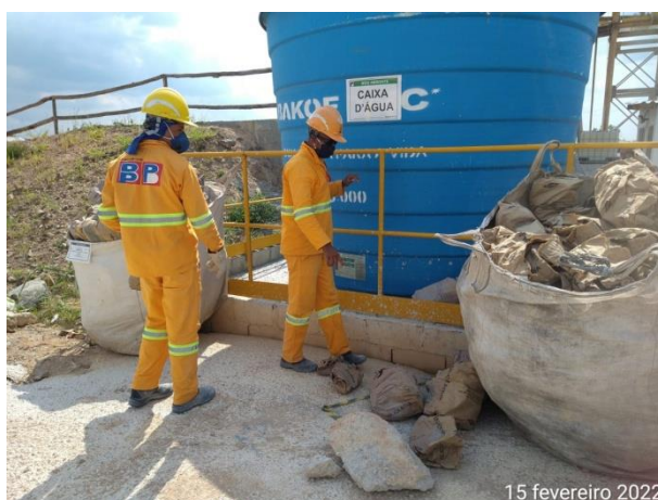
Foto 5 – Limpeza e organização na usina de concreto. Data: (15/02/2022)
