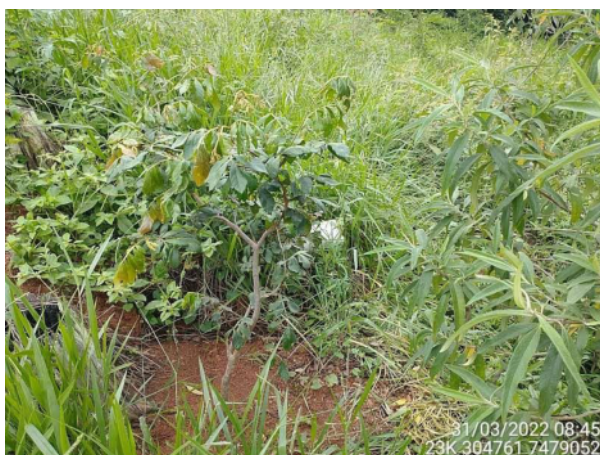
Foto 11 – Canalização do banheiro diretamente no solo.
