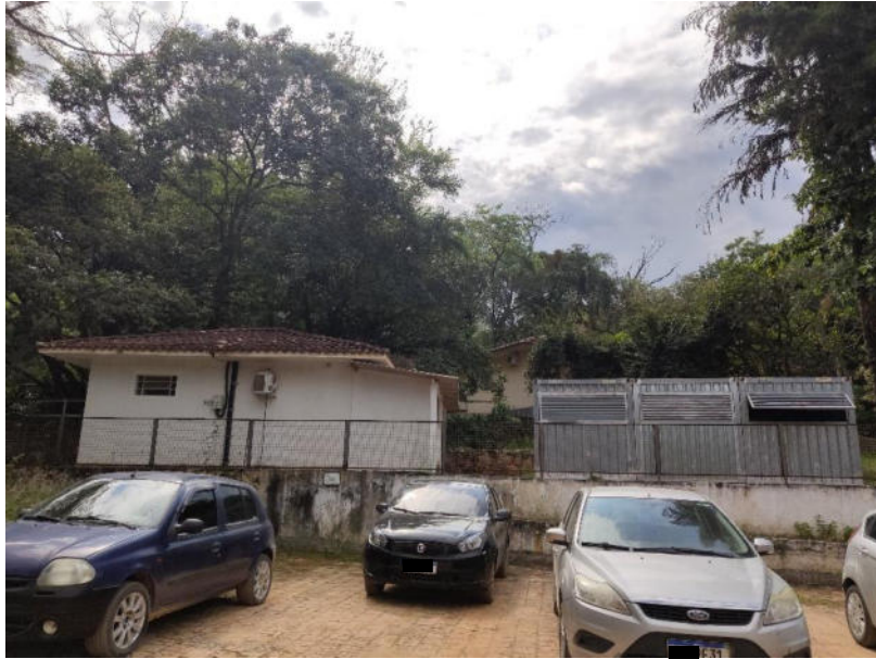
Foto 3 – Antigas edificações Fazenda Ingatuba – Atual Canteiro Administrativo
