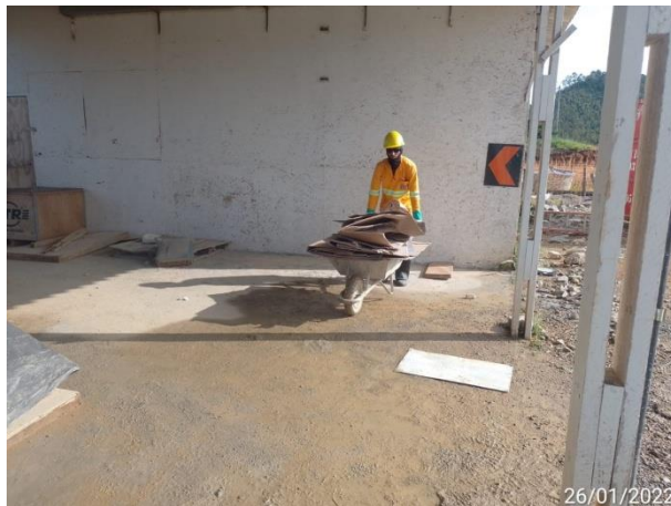
Foto 3 – Limpeza e organização nas frentes de serviços. Data: (26/01/2022)
