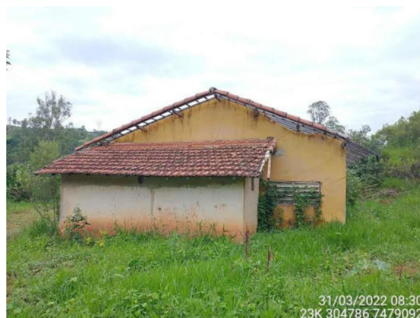
Foto 12 – Parte externa da edificação.
